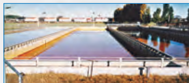
Absetzbecken zur Filterspülwasserbehandlung und Schlammstapelbecken
