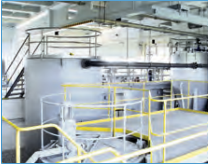
Kalkanlage zur pH-Wert-Einstellung
