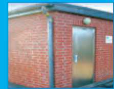
Mess- und Regelschacht Gommern
