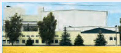
Blick auf das Wasserwerk-Gebäude
