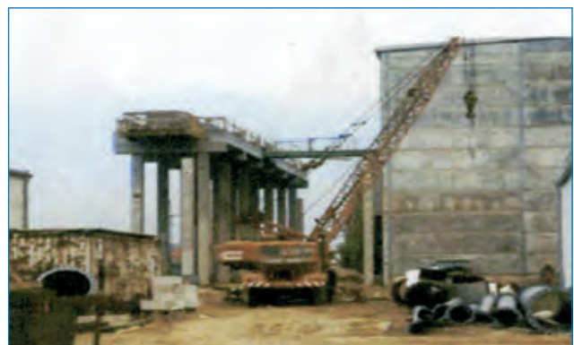
Wasserwerk Lindau im Bau - 1992
