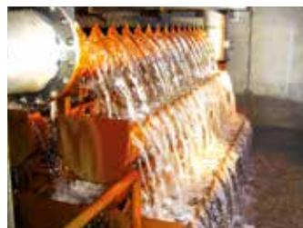
Kaskaden zur Belüftung / Entgasung
