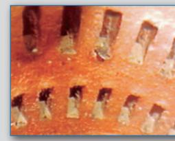
Durch die Schlitze der Filter strömt das Grundwasser in die Brunnen.
