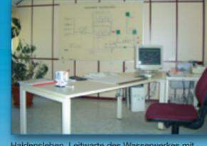
Haldensleben, Leitwarte des Wasserwerkes mit Verbindung zum zentralen Prozessleitsystem in Magdeburg
