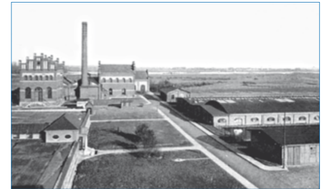
Elbewasserwerk in Magdeburg-Buckau ab 1859
