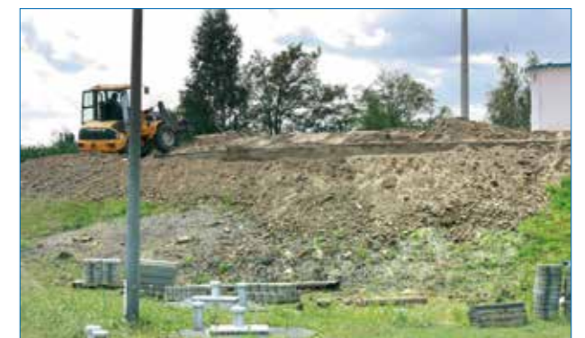
Sanierung des Hochbehälters Leitzkau
