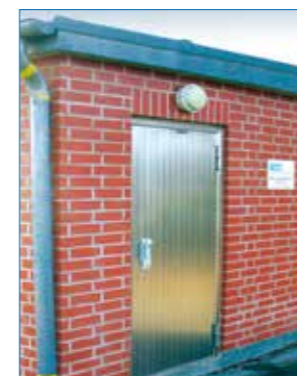
Mess- und Regelschacht Gommern
