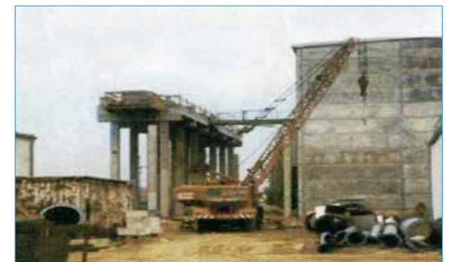
Wasserwerk Lindau im Bau - 1992
