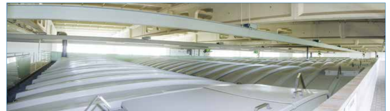
Schnellfilter zur Enteisenung / Entmanganung Wasserwerk Lindau
