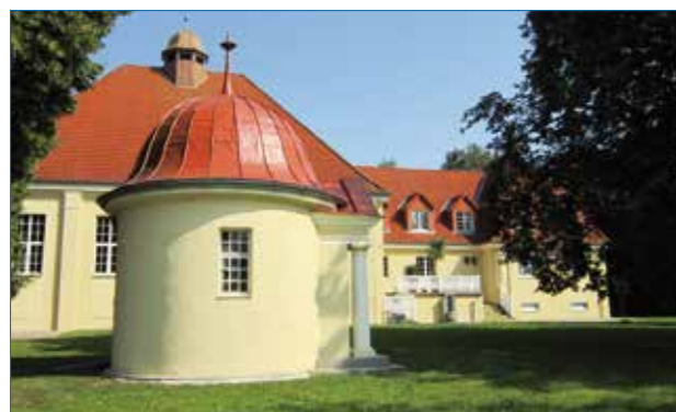
Stützpunkt Oschersleben im ehemaligen Wasserwerk
