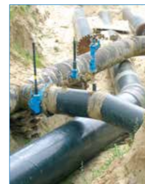
Arbeiten am Rohrnetz
