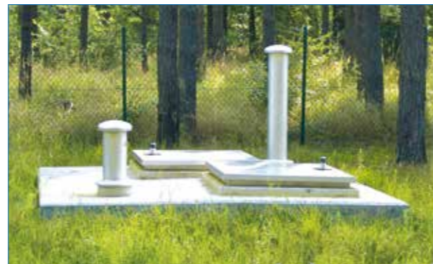
Brunnen mit Einstiegsbauwerk
