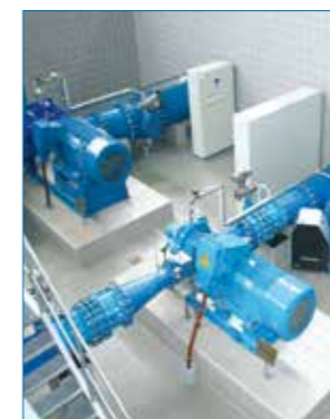
Reinwasserpumpen im WW Colbitz
