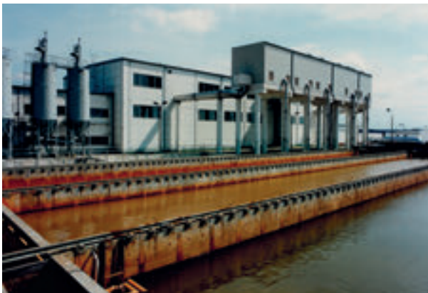
Blick auf das Wasserwerk mit Chemikalienanlage und Filterspülwasserbehandlung
