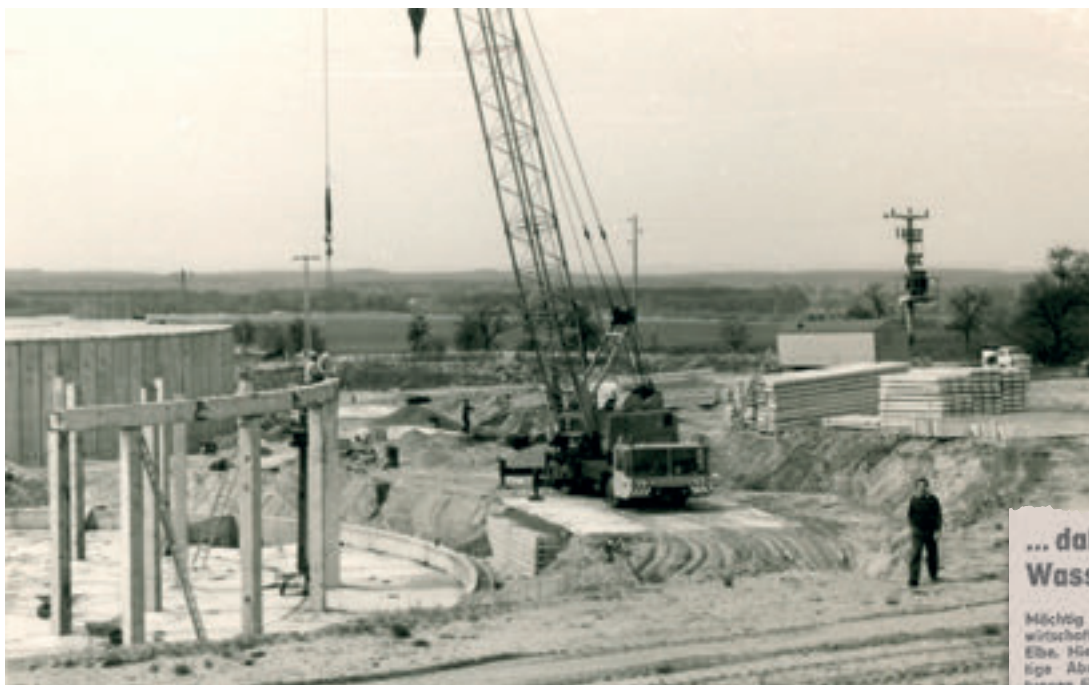
Die Baustelle für Hochbehälterbau
