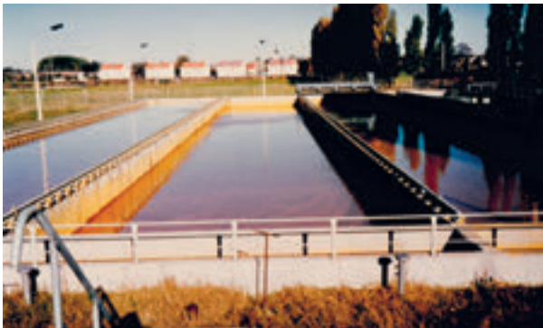
Blick auf die Filterspülwasserabsetzbecken
