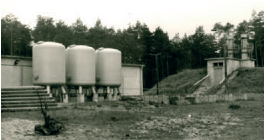
Ein neues Wasserwerk entsteht in der Nähe von Kuhberge
