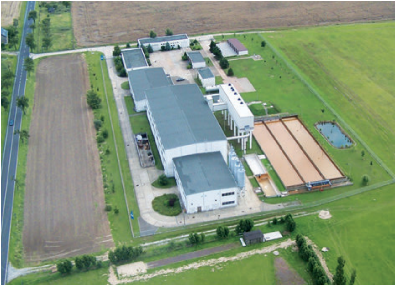
Gesamtansicht des Wasserwerkes Lindau aus der Luft
