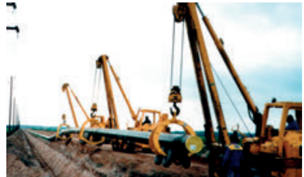
Die Verlegung der Stahlrohrleitung DN 500
