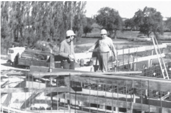
Betonarbeiten für den Neubau des Wasserwerkes Lindau
