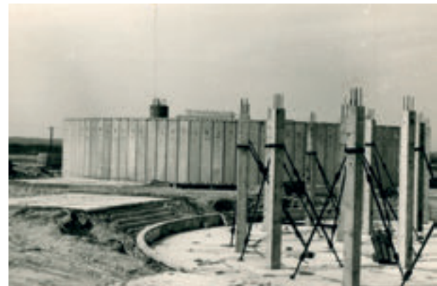
Errichtung der Stützpfeiler für den Hochbehälter Leitzkau
