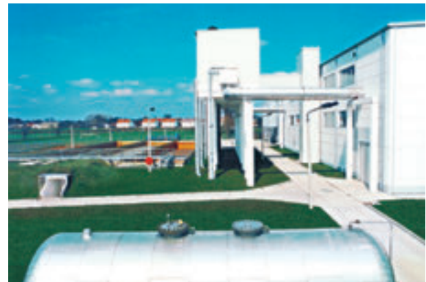
Ansicht vom neuen Wasserwerk Lindau von 1993
