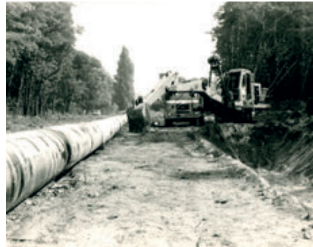
Die Verlegung von Stahlrohren für die 35 km lange Fernwasserleitung
