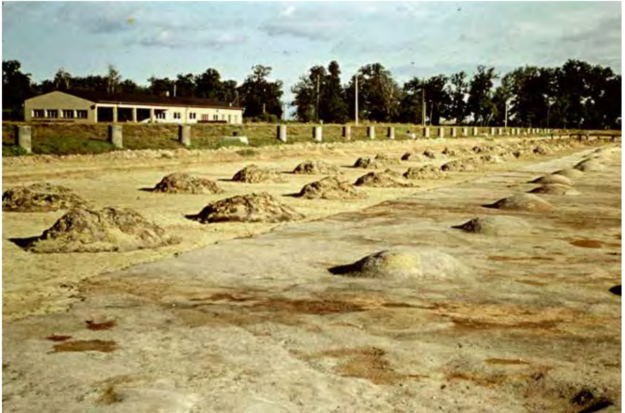
Stillgelegtes Infiltrationsbecken vor der Beräumung
