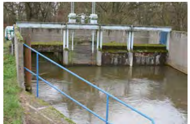
Zulauf zum Freigefällekanal
