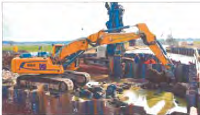
Mit schwerem Gerät wird das alte Ohrewehr abgerissen. Zuvor wurde das Flussbett umverlegt.
