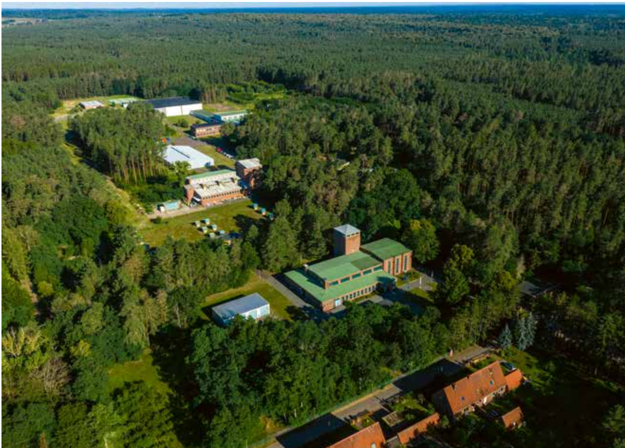
Das alte und neue Wasserwerk Colbitz aus der Luft
