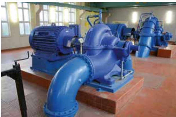
Pumpe 3 mit 0,5 \text{ m}^3/\text{sec} .
