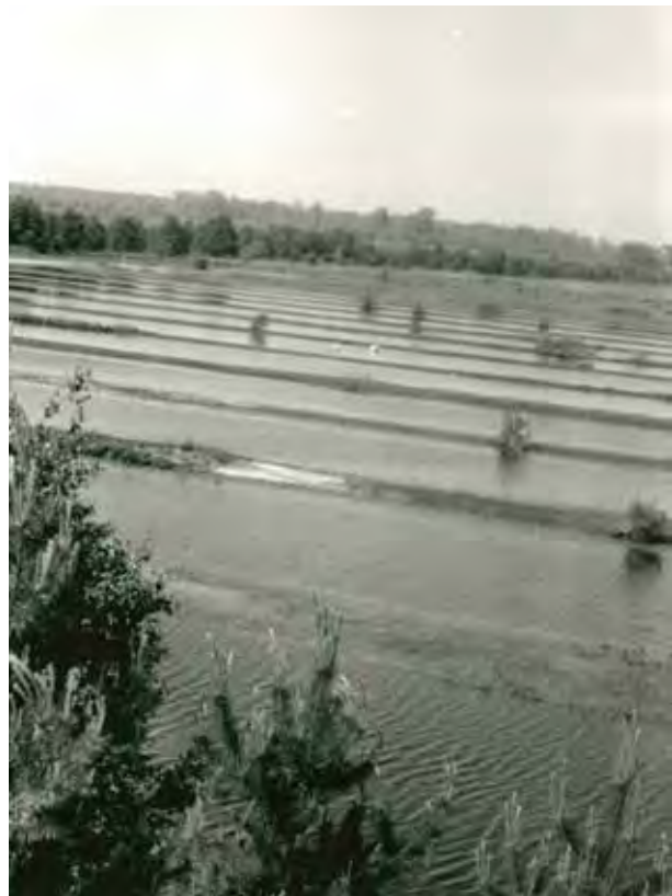
Die Versickerungsbecken mit Ohrewasser im Vollstau
