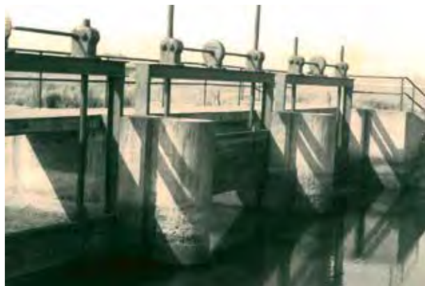
Wehr zur Regulierung des Ohrewasserabflusses
