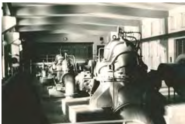
Kreiselpumpen fördern das Ohrewasser auf die Hochfläche der Heide
