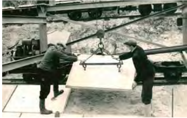
Verlegung der Betonfertigteile im Freigefällekanal
