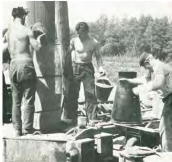
Die Errichtung der Brunnen in der Ostfassung II
