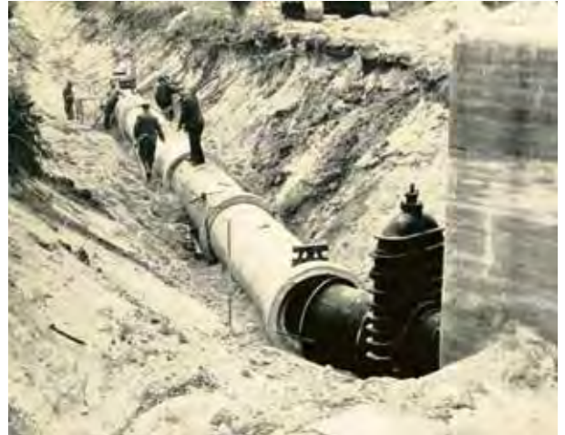
Bauarbeiter bei der Verlegung einer Betonrohrleitung
