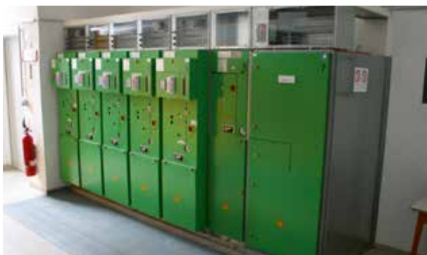
Neue 20kV-Elektroanlage
