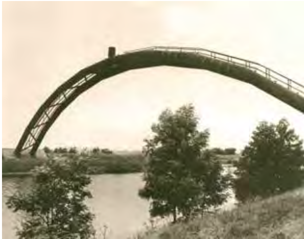
Rohrbrücke für die 2. Hauptleitung bei Meitzendorf über den Mittellandkanal
