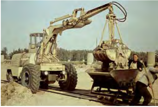
Per Radlader wurden die abgeschippten oberen Bodenschichten aufgenommen und per Feldbahn abtransportiert
