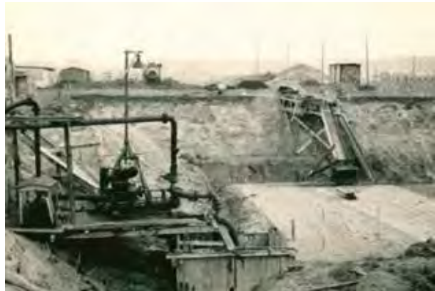
Baugrube für das Pumpwerk Satuelle, Oktober 1958
