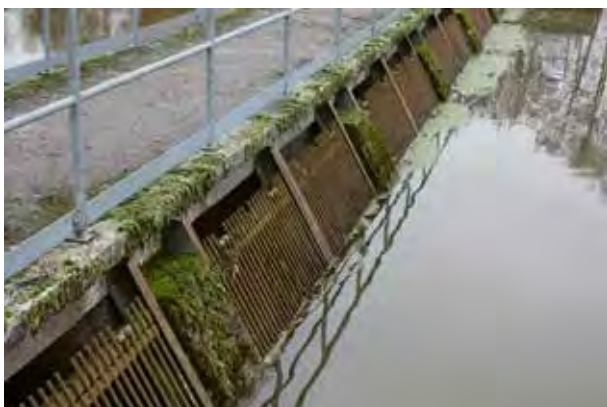
Grobrechen für das Zurückhalten von Schwemmgut aus der Ohre
