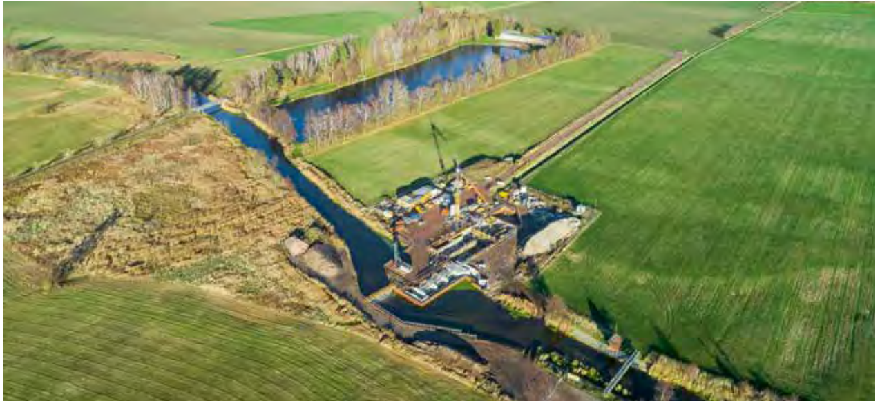
Ohrewehr und Pumpwerk im Bau, Dezember 2021
