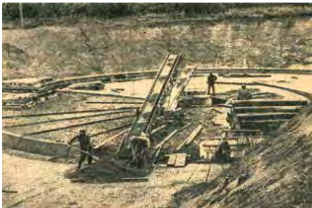
Großlysimeteranlage im Bau, 1968
