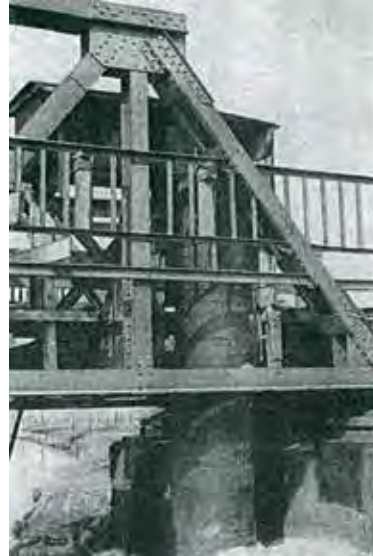
Versuchsfilteranlage an der Ohre
