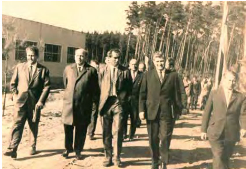
Der Oberbürgermeister von Magdeburg und der Direktor des VEB Wasserversorgung und Abwasserbehandlung Magdeburg Harry Schwarz beim Rundgang durch das neue Wasserwerk
