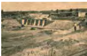
Einlaufbauwerk des Pumpwerks Satuelle mit einem vorgeschalteten Ausgleichsbecken
