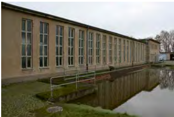
Westseite des Pumpwerkes Satuelle
