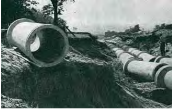
Bau der Druckrohrleitungen vom Pumpwerk Satuelle zum Freigefällekanal
