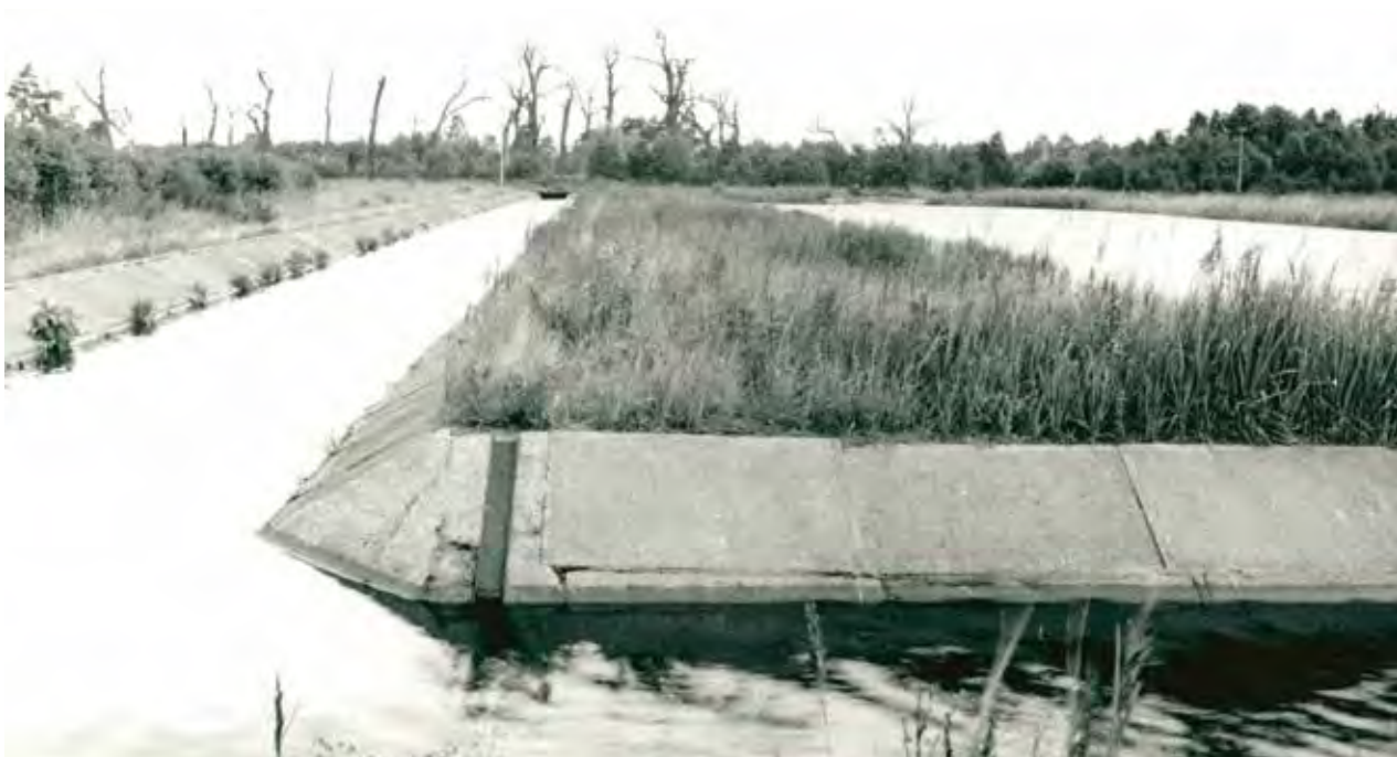
Die Grundwasseranreicherungsbecken nach der Inbetriebnahme
