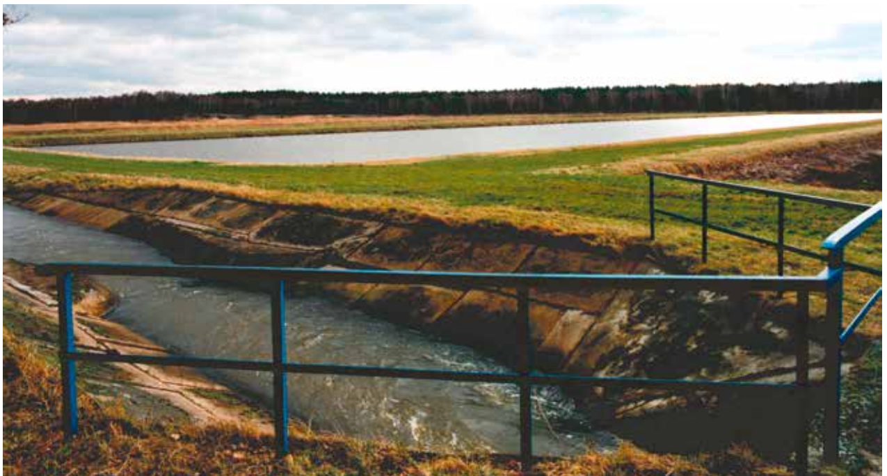
Blick auf den Ohrewasserzulauf und Versickerungsbecken
