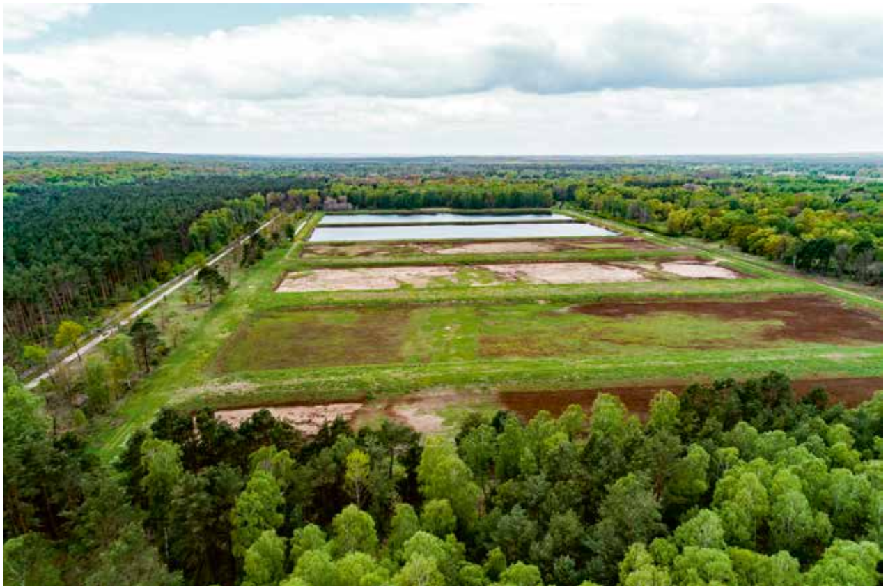
Die 6 Versickerungsbecken zur Grundwasseranreicherung, 2020
