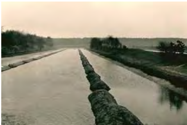
Grundwasseranreicherungsbecken im Wasserwerk Haltern bei Gelsenkirchen
