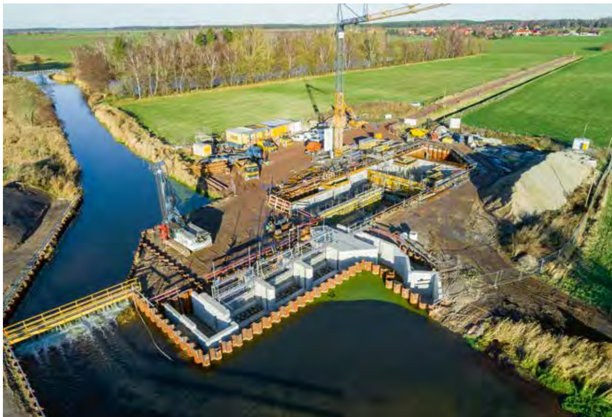
Neubau Ohrewehr und Pumpwerk Satuelle, Dezember 2021
