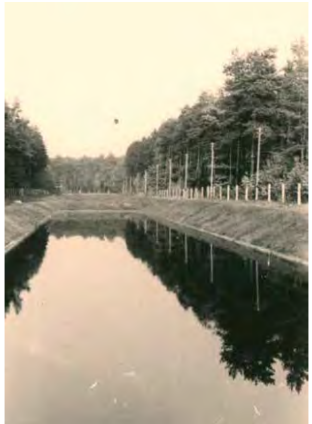
Infiltrationsbecken am Standort Wasserwerk Káraný-Sojovice
