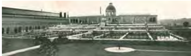
Stufenfilter für die Voreinigung des Elbe-Wassers.
