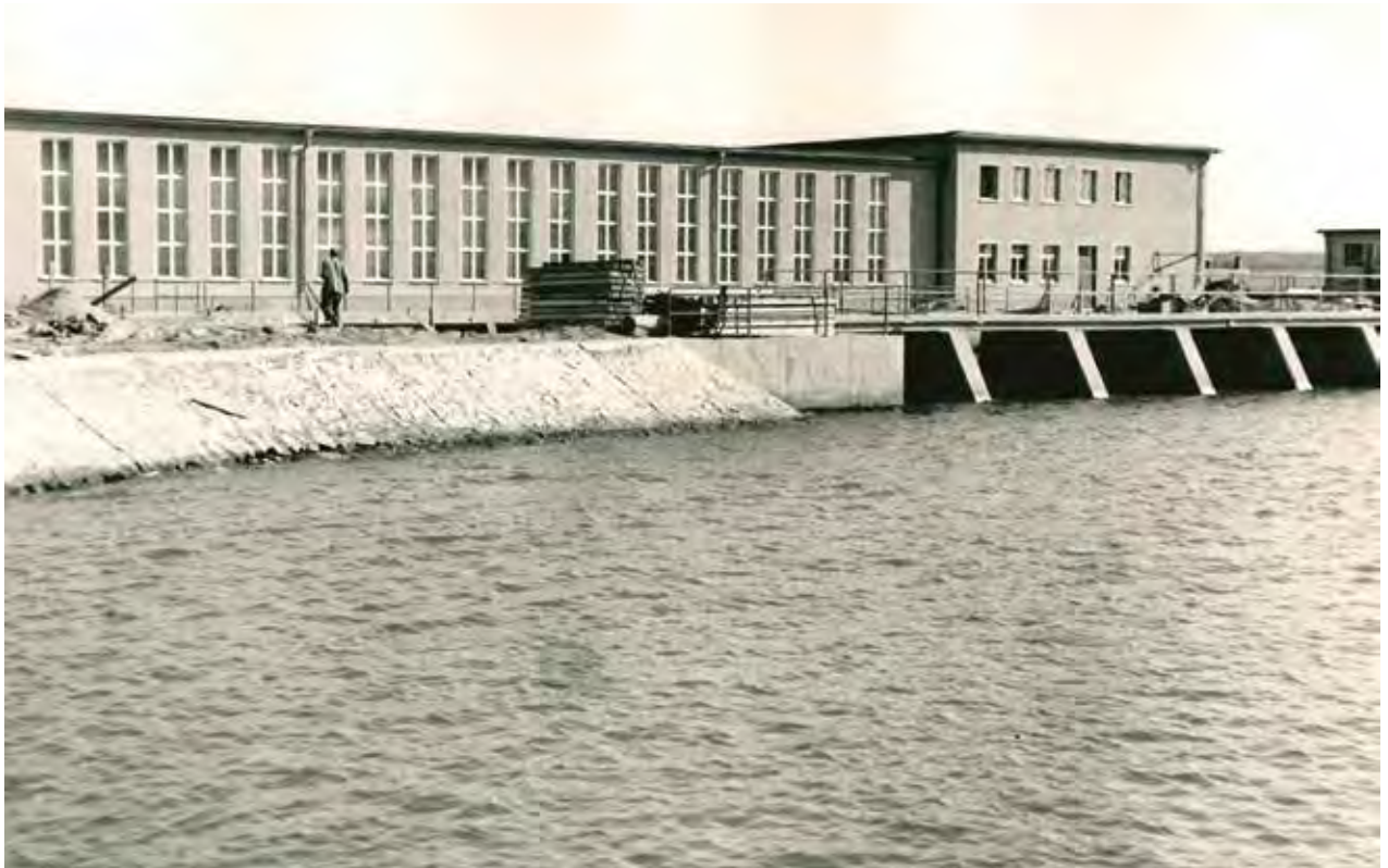
Das Pumpwerk Satuelle mit Vorbecken und dem Einlaufbauwerk
