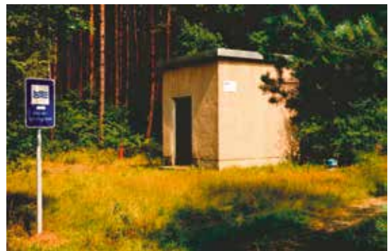
Obertägiger Brunnenabschluß der Ostfassung II
