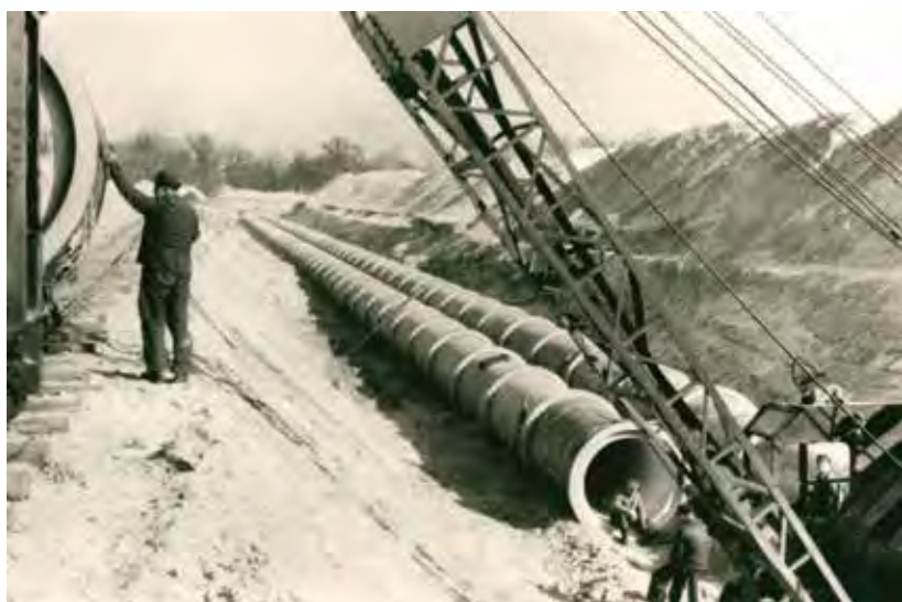
Verlegung der 2. Hauptleitung vom Wasserwerk Colbitz nach Magdeburg
