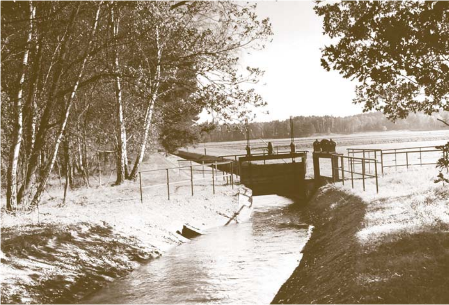
Offener Kanal zu den Versickerungsbecken
