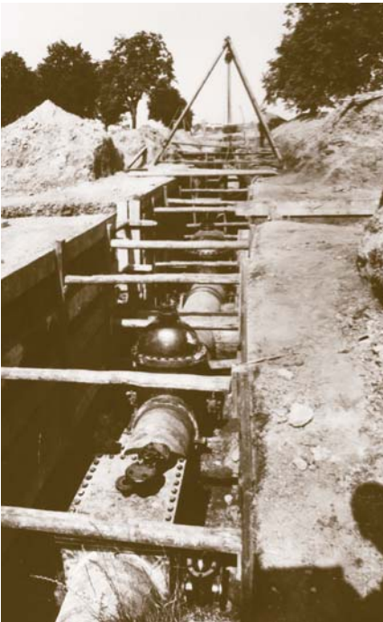
Bau der Heideleitung nach Magdeburg um 1930
