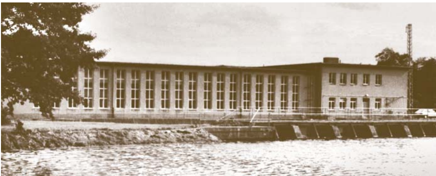
Einlaufbecken und Pumpwerk Satuelle
