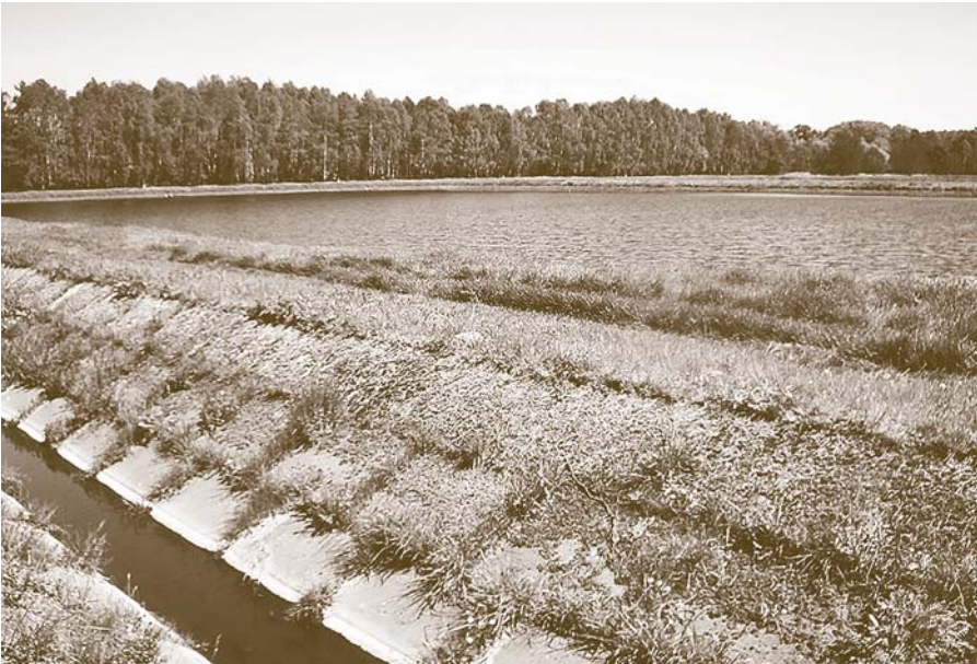
Versickerungsbecken zur Grundwasseranreicherung
