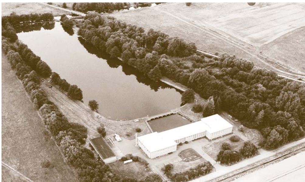
Ohrwasserentnahme am Pumpwerk Satuelle für die Grundwasseranreicherung
