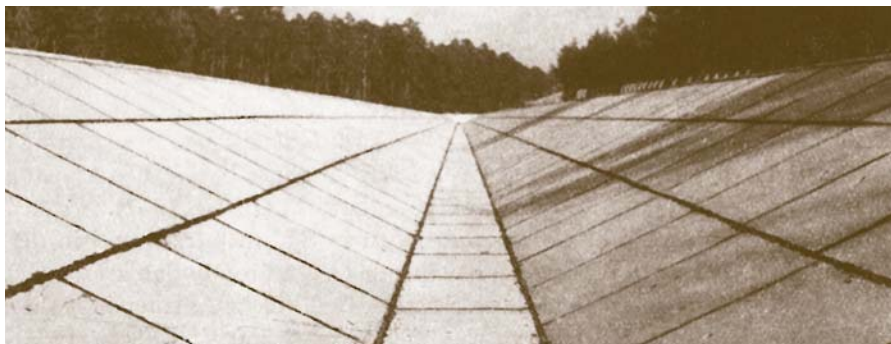
Offener Kanal zur Überleitung von Ohrewasser zum Versickerungsgebiet
