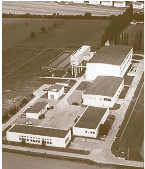
Grundwasserwerk Lindau im Westfläming
