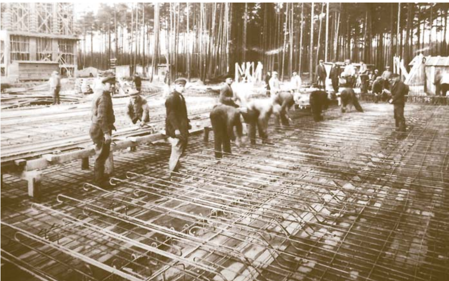
Verlegung der Eisenarmierung für den Trinkwasserbehälter
